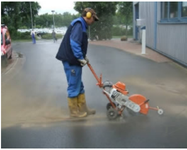
Zunächst wird eine Nut in den Asphalt bzw. Beton geschnitten.
